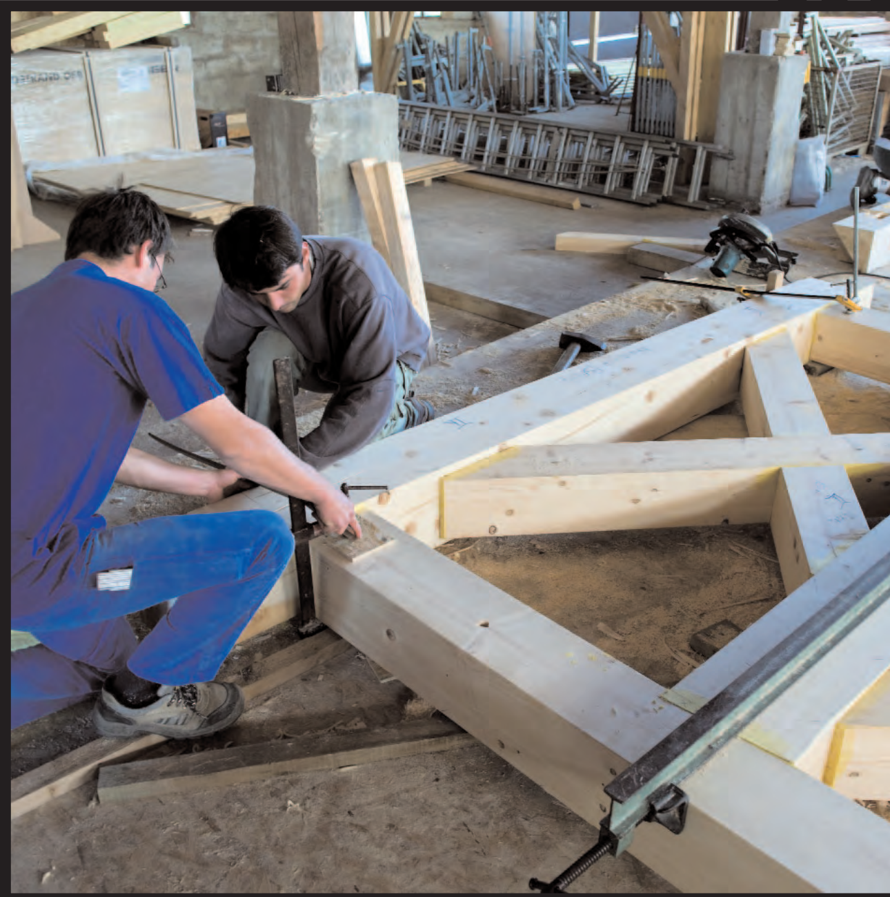
Réalisation de la charpente pour la rénovation de l'église des Nans, à l'entreprise Angonnet. Une bonne part du travail de couvreur est effectuée en atelier.
