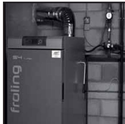
Équipement moderne pour maison particulière permettant de chauffer 500 m 2 de plancher et une piscine. Le chauffagiste installe les équipements, effectue les réglages et assure la maintenance.
