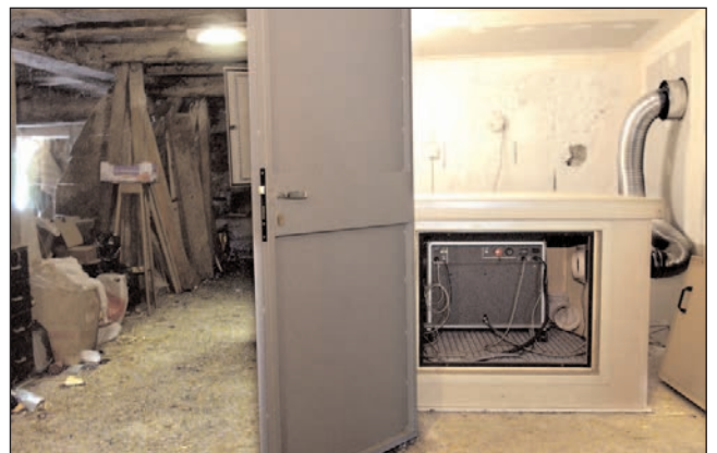
A titre expérimental, EDF a installé dans l'écurie d'une ferme isolée du haut Doubs (Pierrefontaine les Varans), une pile à combustible «résidentielle». Elle fournira à la place d'un groupe électrogène les besoins en électricité en complément de panneaux photovoltaïques visibles sur le toit. Photo Laurent Cheviet/collectif dcb
