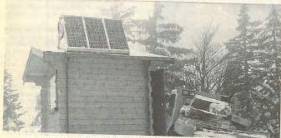
Electrification d'un poste radio-secours du SIDANEP à Nozeroy (39)
