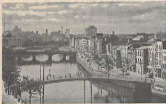
Dublin, une ville insolite aux multiples clins d'œil d'une architecture en fin de cycle
