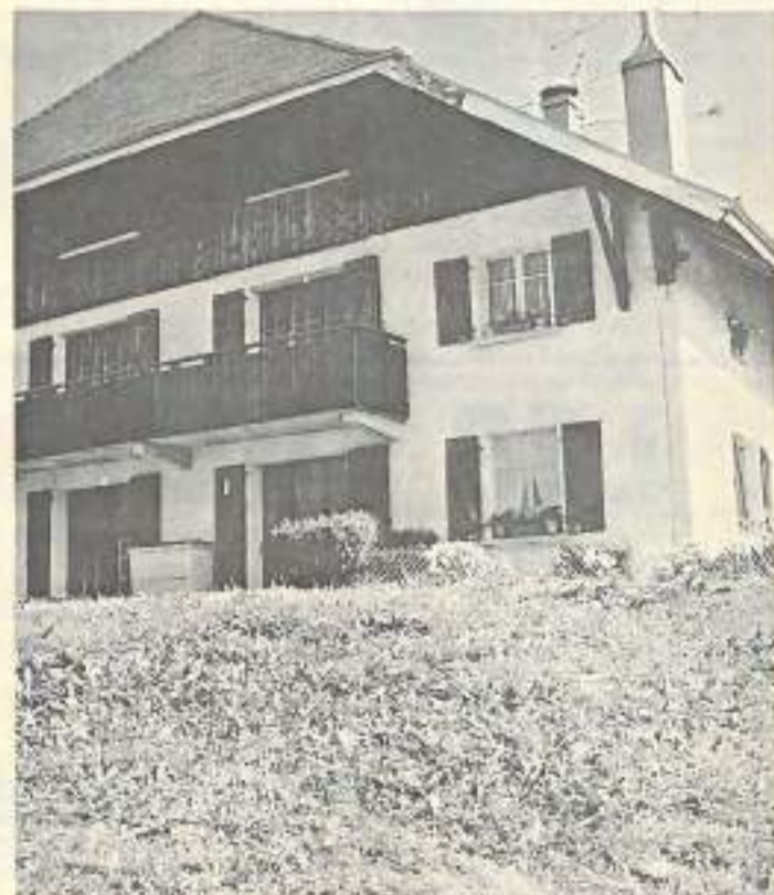
Si elle n'est plus une priorité pour la CAF de Besançon, l'aide financière pour la construction de centres de vacances reste un secteur important de son action sociale. Ainsi, un soutien décisif a été apporté pour les travaux d'extension du centre de vacances de la MJC Besançon au Loutellet près de Métabief.
