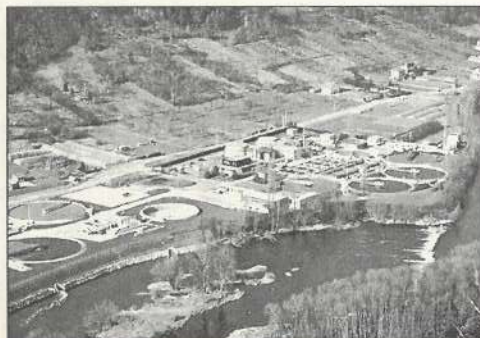
Station d'épuration de Port-Douvot (Besançon). L'assainissement et l'épuration occupent 57 000 personnes en France.
